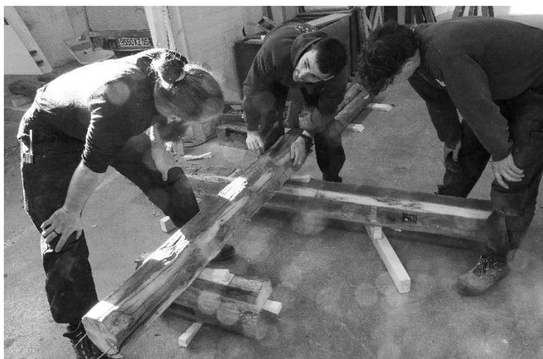
Pour le travail de réalisation de charpente, les deux principes du lignage et du piquage sont particulièrement adaptés pour les bois vrillés, peu ou mal équarris, où l'équerre n'est d'aucune aide. Le piquage consiste après avoir mis les pièces de bois sur ligne (empilage des bois sur l'épure) à marquer à l'aide du fil à plomb de charpentier l'endroit où seront assemblées celles-ci.
